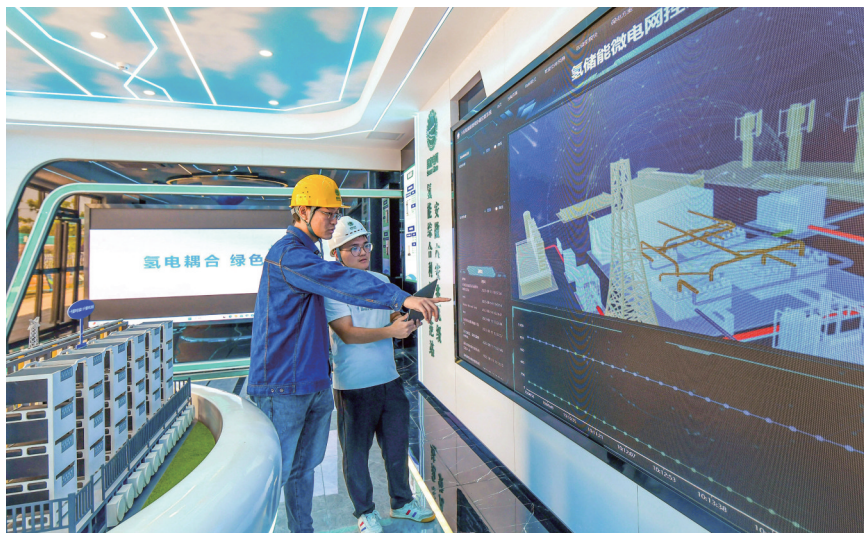
技术人员在安徽六安兆瓦级氢能综合利用示范站调试微电网控制系统。 许婕娟/摄
